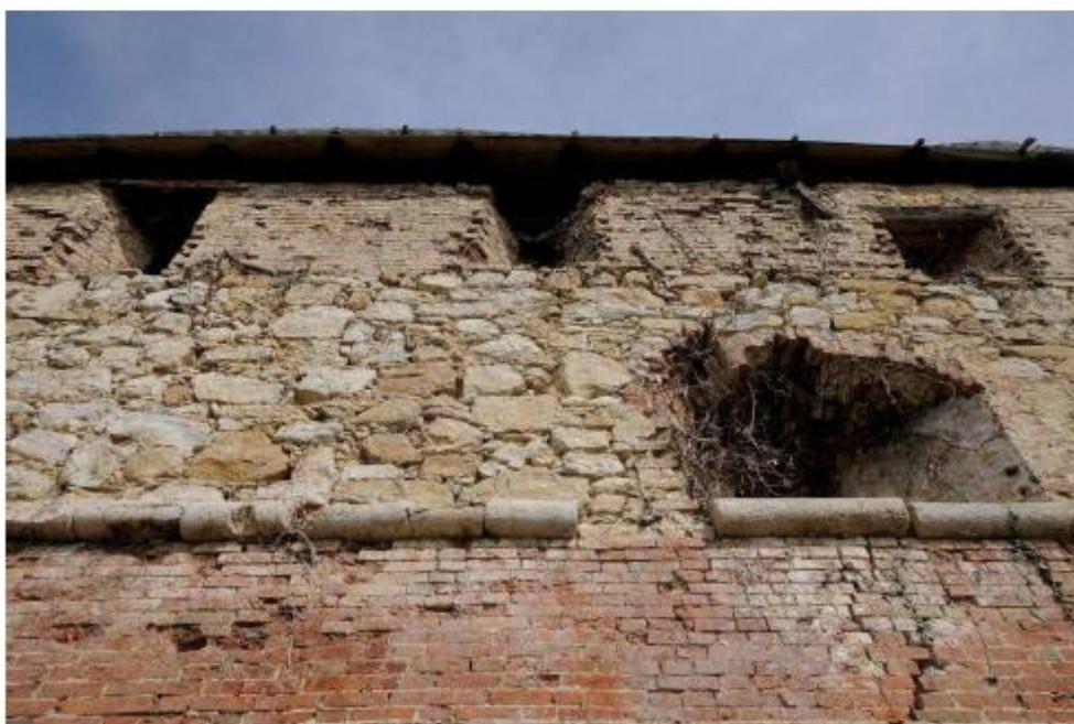
Sl. 13. Detalj južnog pročelja, prvi kat, vidljiva znatna oštećenja kordonskog vijenca i niša strijelnica.
