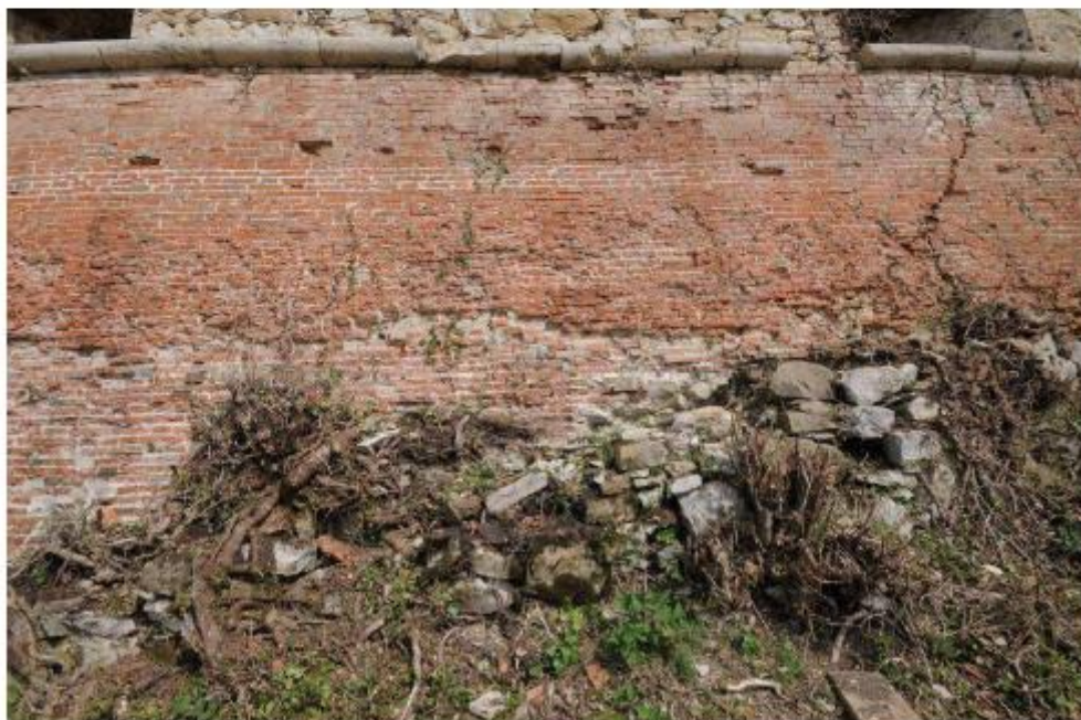
Sl. 11. Detalj baze južnog pročelja, vidljiva znatna oštećenja opečne građe.
