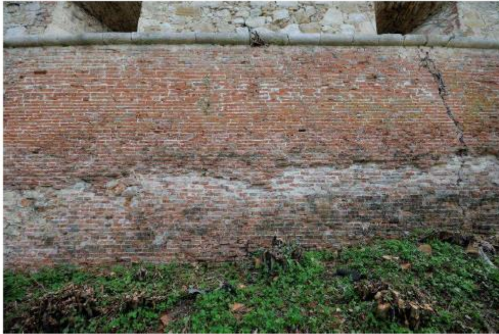
Sl. 10. Detalj baze zapadnog pročelja, vidljiva znatna oštećenja opečne građe.
