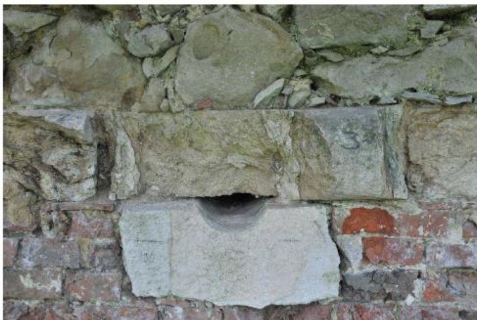
Sl. 32. Sjeverozapadno pročelje, kameni izliv za oborinsku vodu u razini prizemlja, ispod kordonskog vijenca.
