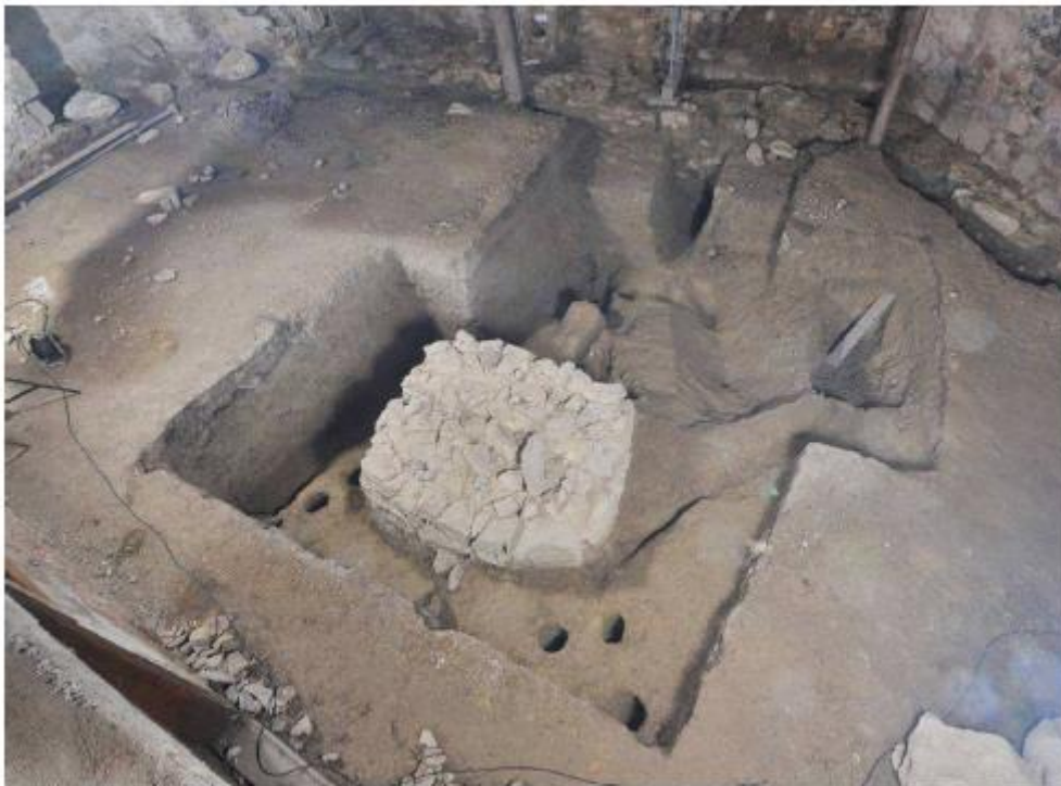
Sl. 30. Kameni temelj koji je nosio gredu krovišta otkriven arheološkim istraživanjima.
